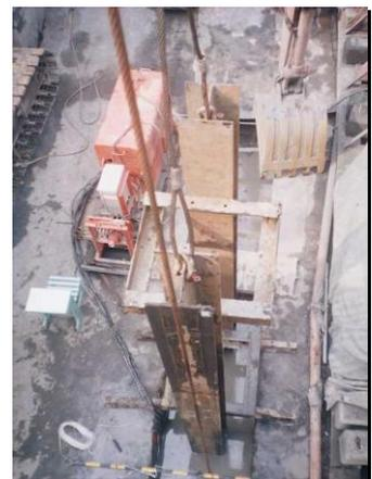
圖十六 H型鋼架拔起
