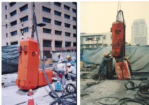
圖九 L 型機吊放於 H 型鋼作業實務
