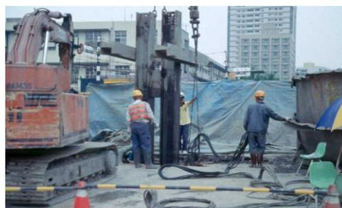
圖十 L 型機之 H 型鋼托架
