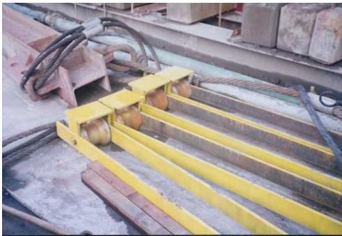
圖十九 鋼筋籠吊放位移滑輪組
