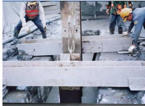
圖十四 H型鋼托架放置
